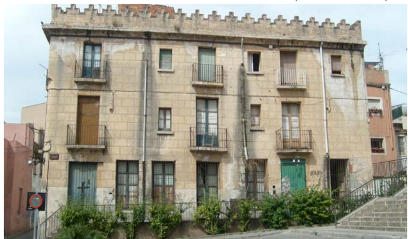
Façana del Castellet de Can Frias a la Plaça Barberà : foto jexpósito
